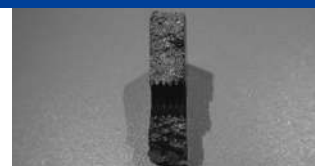
Разрушенная поверхность металла
